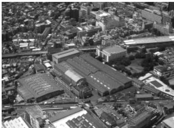
玉川製造所全景
